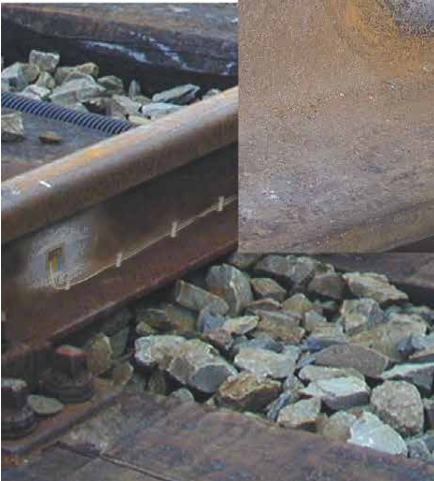
Experimentelle Untersuchungen an einer Eisenbahnschiene
